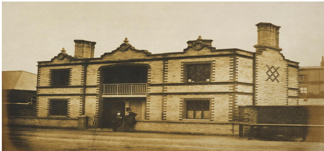
Figura 3 – Fotografia das Casas modelo para moradia de trabalhadores construídas, de autoria Claude-Marie Ferrier, próximas ao Pavilhão Central, o Crystal Palace , na Exposição Universal de 1851
