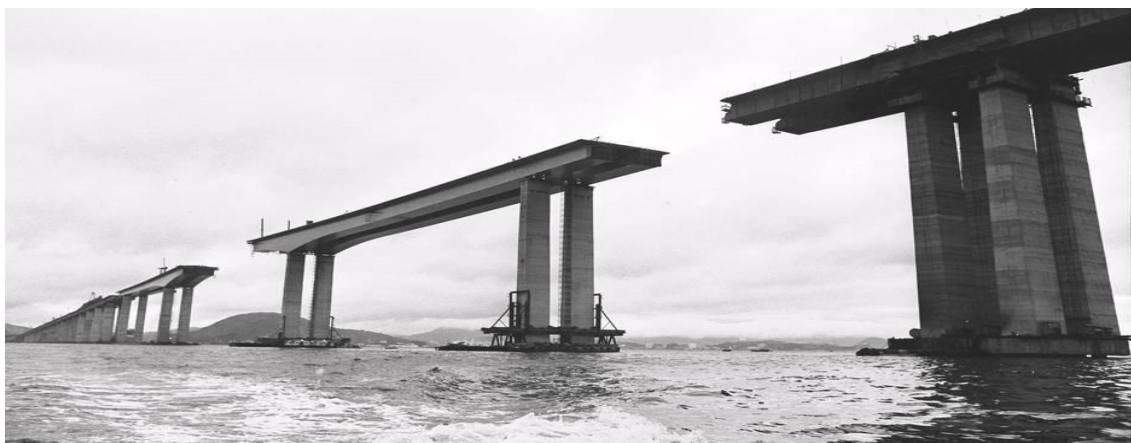
Figura 6: Vão lateral da Ponte Rio-Niterói
