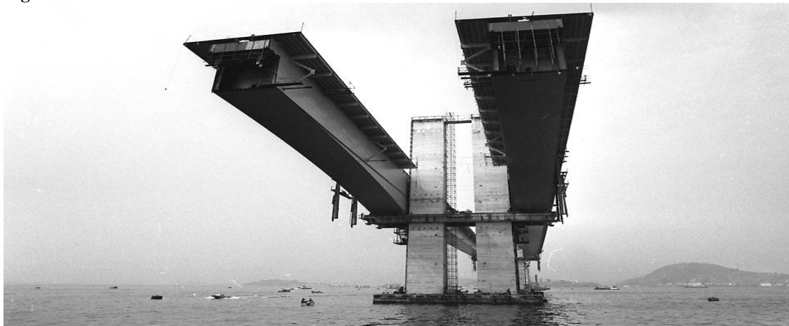
Figura 5: Vão lateral da Ponte Rio-Niterói
