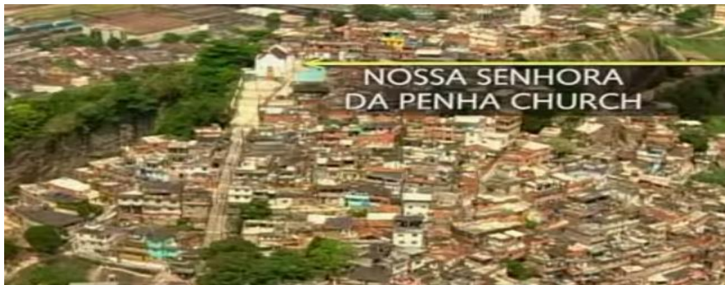
Foto 12 – Vista do alto da escadaria de acesso a Igreja Nossa Senhora da penha.
