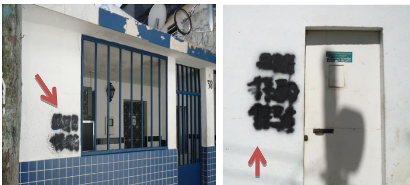
Foto 4 – Imóveis que tiveram a marcação da SMH “apagada”, sem a reparação.
