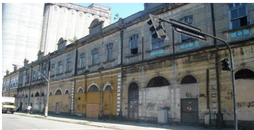
Foto 12 – Galpão de Artes da Rua Venezuela
