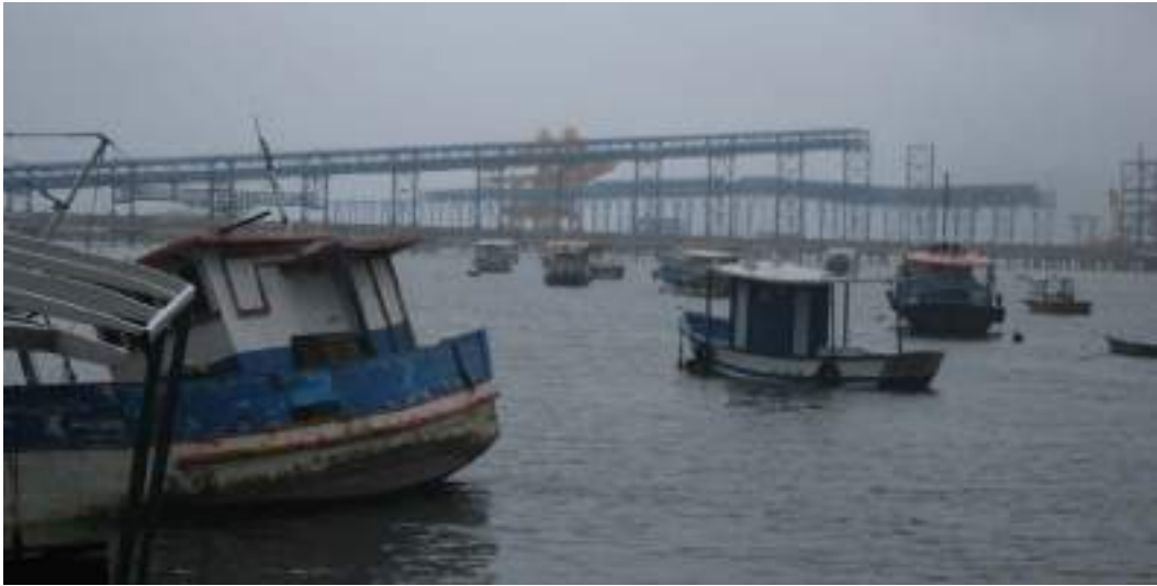
Figura 3 - Barcos de pesca artesanal e, ao fundo, píer do Porto Sudeste em estágio avançado de construção.
