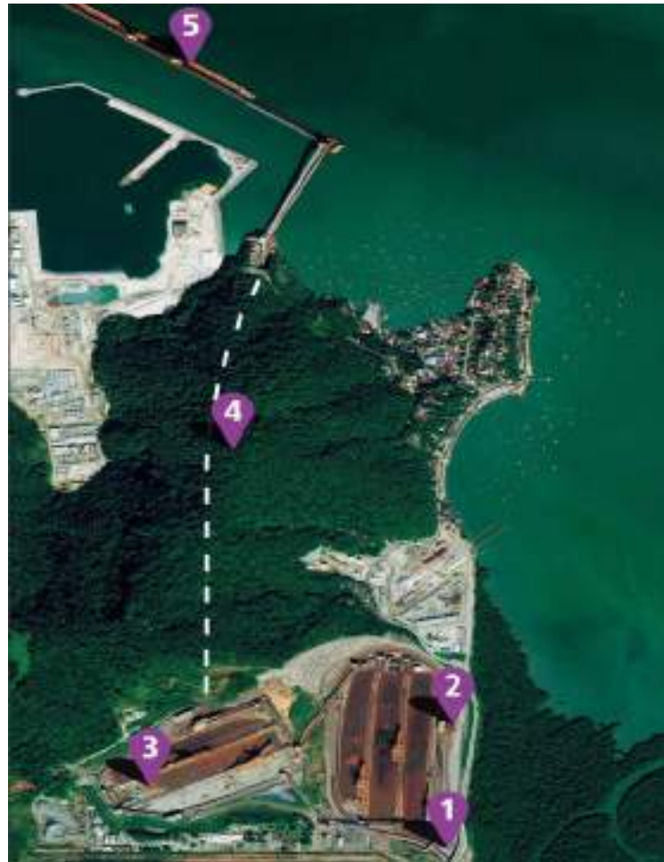
Figura 12 - Etapas de chegada do minério no Porto Sudeste.
