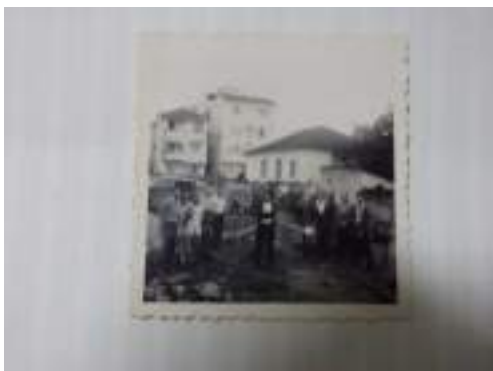
Figura 20: Lançamento da Pedra Fundamental
