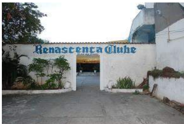
Figura 17: Fachada do Renascença Clube, bairro do Andaraí (RJ)
