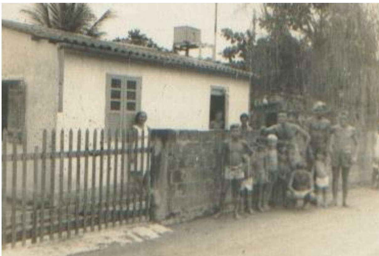
Figura 33: Construção de alvenaria na Colônia. Foto cedida por José Luiz de Castro Ferreira. 19??.
