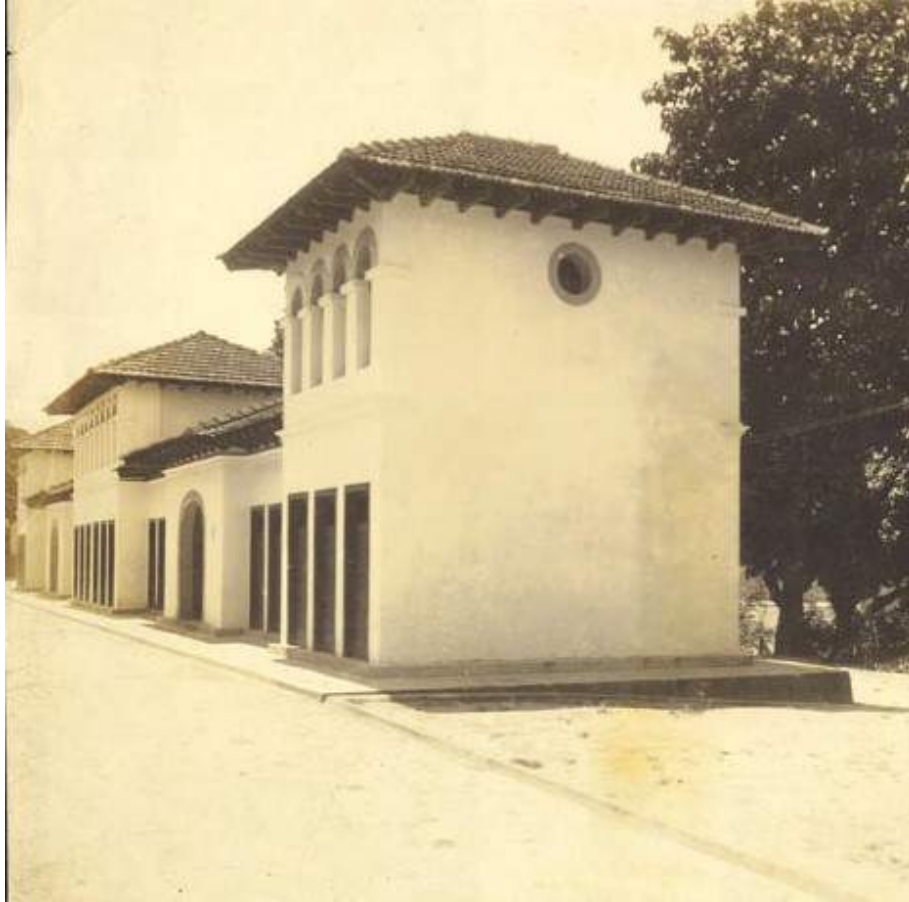
Figura 7 - Pavilhão sanitário após ser reformado
