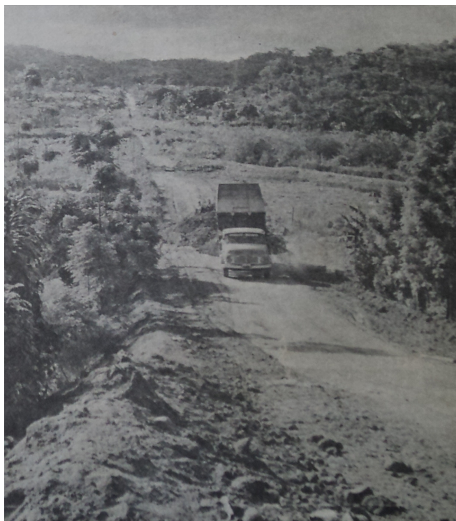
Fotografia 5: Reparo em estrada para escoamento da produção rural. Foto publicada na “A Tribuna Especial de Rio Bonito”, Casa da Cultura Hélio Nogueira, Rio Bonito/RJ, 1981, p.7.
