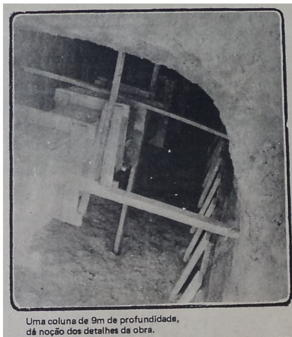
Fotografia 18. Coluna de 9 m de profundidade do Colégio Municipal de Rio Bonito. Foto publicada na “A Tribuna Especial de Rio Bonito”, Casa da Cultura Hélio Nogueira, Rio Bonito/RJ, 1981, p. 05.
