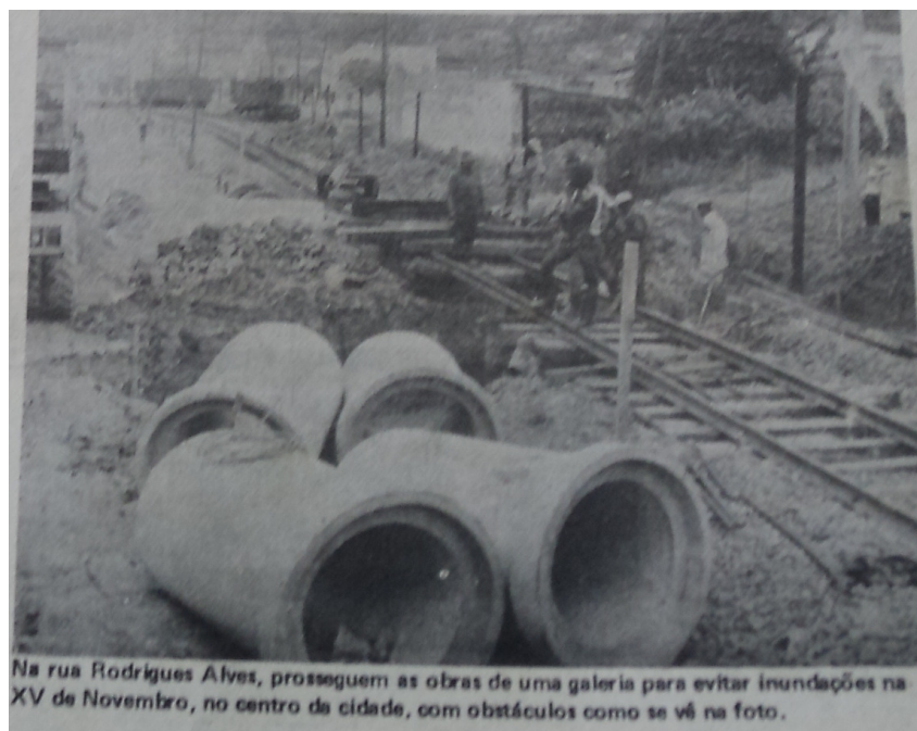
Fotografia 4: Galeria para evitar inundações. Foto publicada na “A Tribuna Especial de Rio Bonito”, Casa da Cultura Hélio Nogueira, Rio Bonito/RJ, 1981, p.6.
