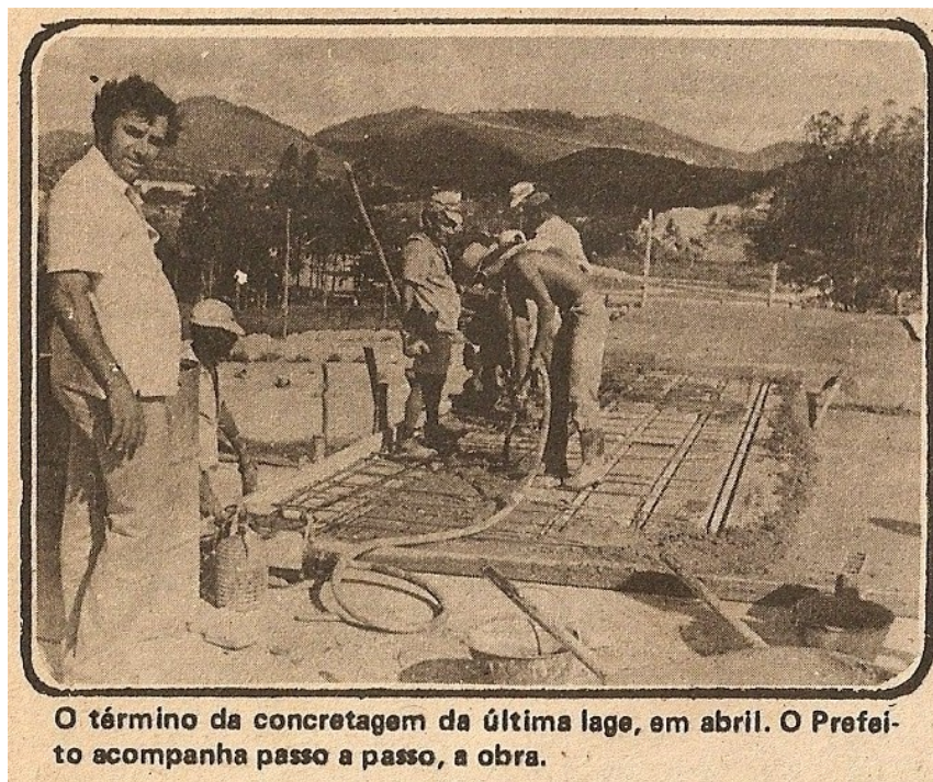
Fotografia 7: Concretagem da última laje do Colégio Municipal de Rio Bonito. Foto publicada na “A Tribuna Especial de Rio Bonito”, Casa da Cultura Hélio Nogueira, Rio Bonito/RJ, 1981, p. 5.
