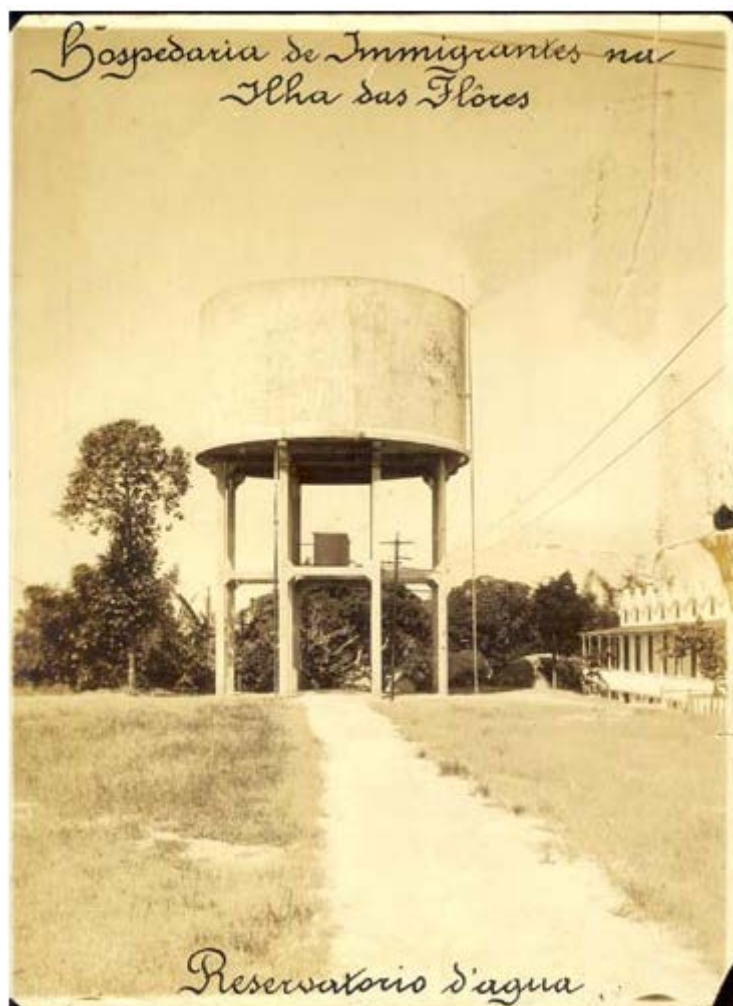
Figura 3 - Caixa d'água construída na Ala Norte
